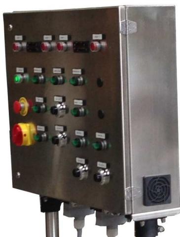
La regolazione della velocità di avanzamento delle palette in teflon (quindi il tempo di cottura del prodotto) avviene mediante la regolazione di un'apposita manopola multigiri posta in un quadro comandi separato ed indipendente.
